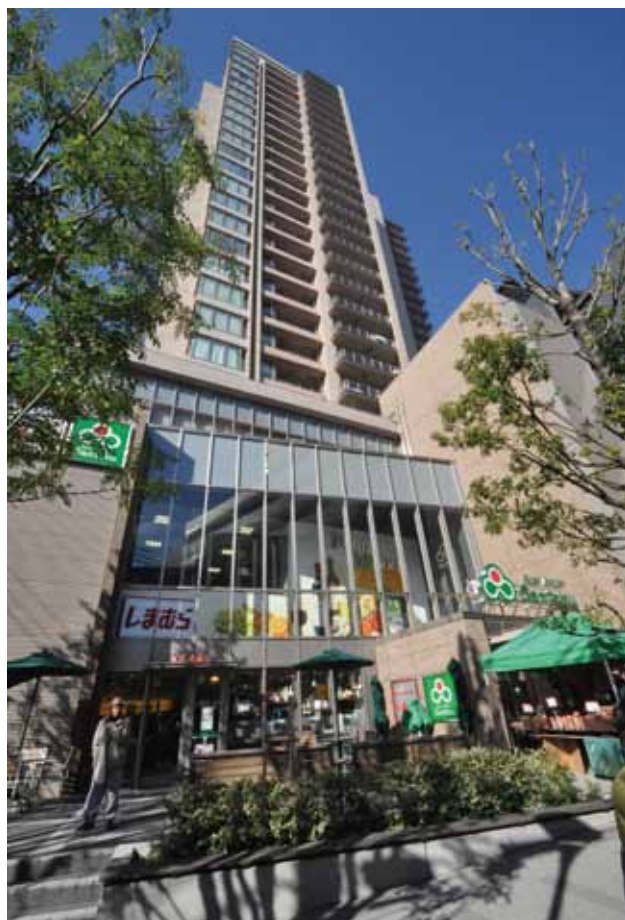
茗荷谷站前Ⅰ街區超高層部分(丁致成攝影)
