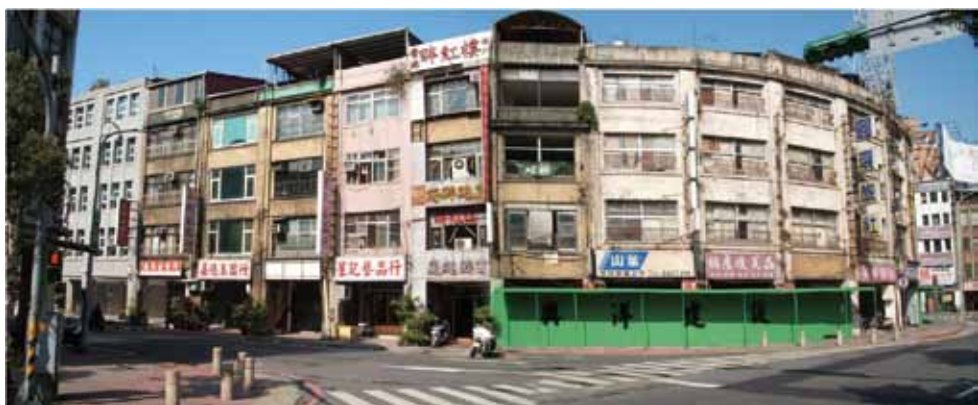
更新前多為四層透天的連棟建築
